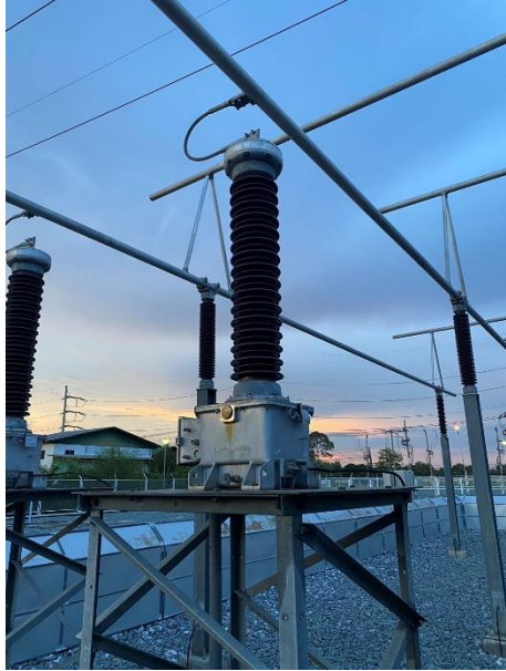
รูปที่ 1 VT 115 kV เฟส B ผลิตภัณท์ TRENCH ที่ สถานีไฟฟ้านครปฐม 2
